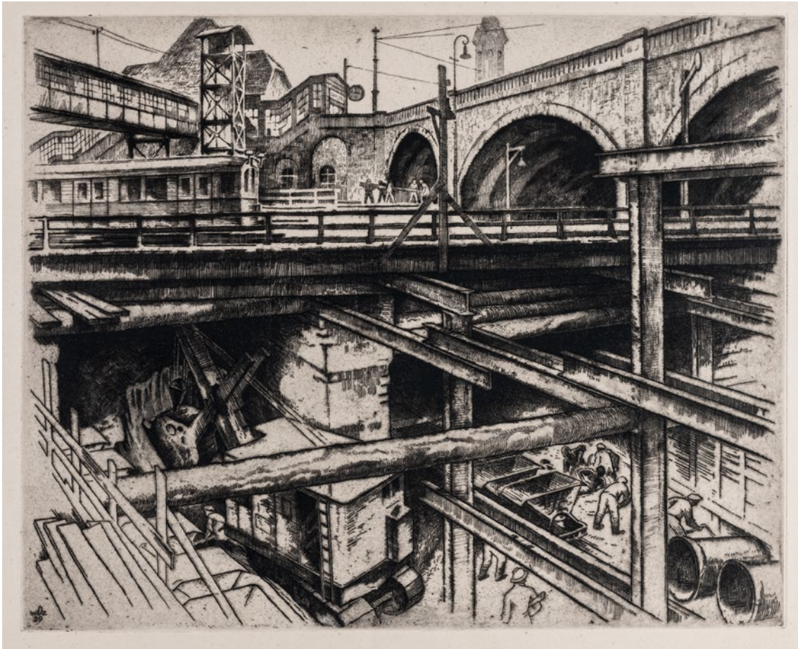
Willy Dzubas: S-Bahnhof Gesundbrunnen während des Baus der U-Bahnlinie D (heute: U 8), 1929
