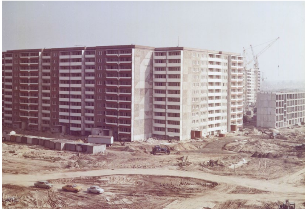
Neubaustelle der Großsiedlung Marzahn
